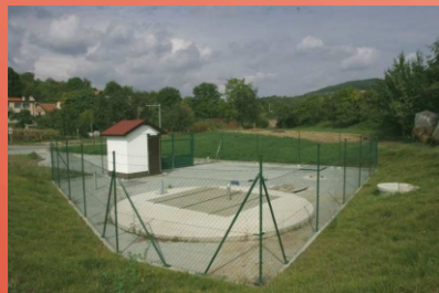
výústní objekt kanalizace v Bohuslavicích
