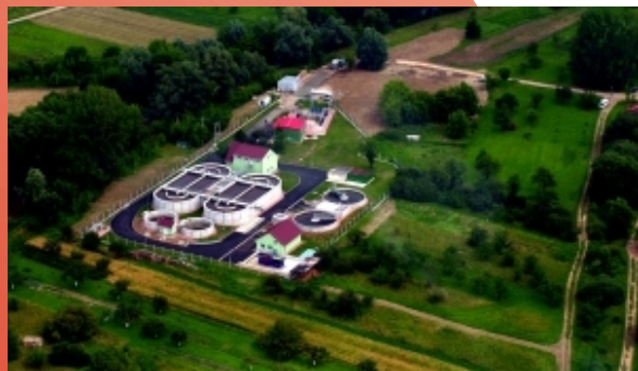
čistírna odpadních vod ve Strážnici
